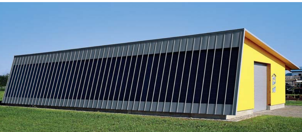
Flexible UNI-SOLAR-Module, werksmäßig auf Zink-Elemente aufgebracht
