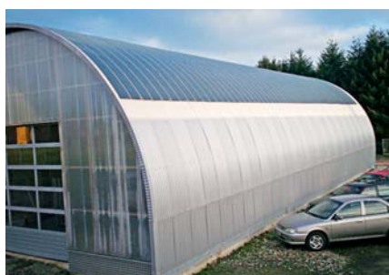
Flexible PV-Module auf gebogenen Metall-Bauteilen
