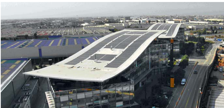
Flexible Module auf der gebogenen Dachfläche eines Logistik-Gebäudes zeigen die gute Verträglichkeit dieser Technologie auch mit ungewöhnlichen Bauformen
