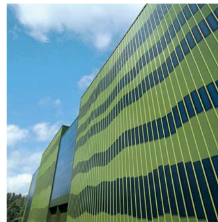
Integration von Dünnschicht-Solar-Modulen in eine Industriefassade
