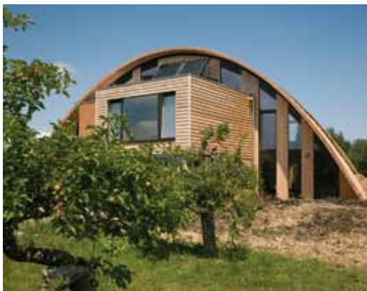
Die Hybridsysteme stammen von der Firma Solimpeks. Sie liefern jährlich 3.400 Kilowattstunden Strom und 12.000 Kilowattstunden Wärme. Fotos: Solimpeks.
