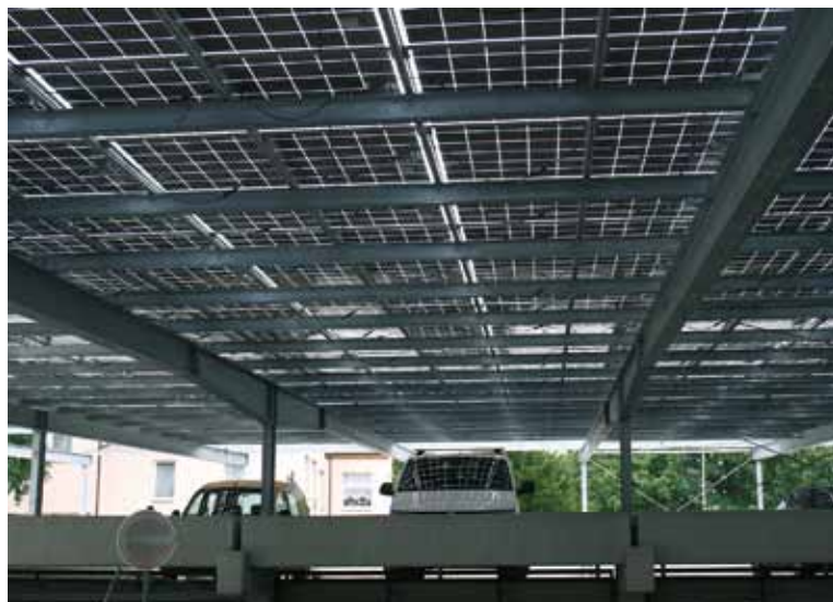
Vom Parkdeck zum Parkhaus: Im Sinne des EEG handelt es sich dabei um ein Gebäude, denn die Module erfüllen auch eine Schutzfunktion: wie ein klassisches Dach. Foto: Willi Ernst
