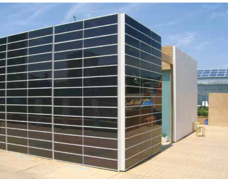
Solarfassade in Valencia, dahinter eine Aufdachanlage: Zunehmend nutzen die Architekten die Vorzüge der Solartechnik, um ihre Gebäude aufzuwerten. Foto: Willi Ernst
