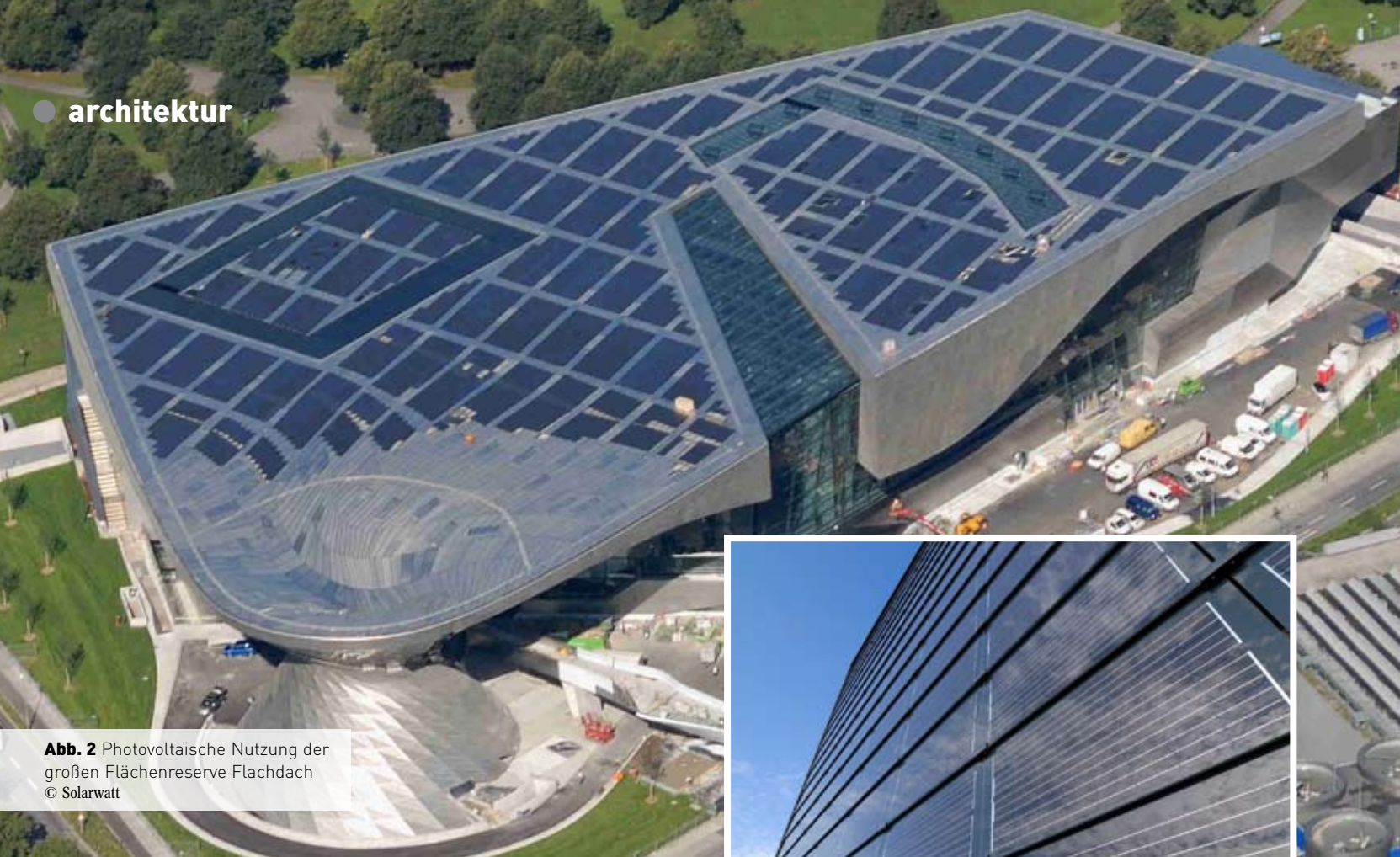
Abb. 3 Integration multifunktionaler PV-Bauelemente in einer vorgehängten hinterlüfteten Fassade © Solarwatt
