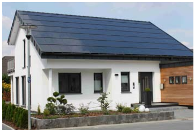
Abb. 5 Ganzheitliche Dachgestaltung mit einem multifunktionalen Indachsystem aus Dünnschichtmodulen © Würth Solar
