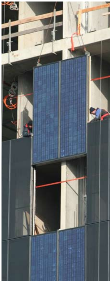
Abb. 6 Vorgefertigte multifunktionale Fassaden-Bauteile © ertex solar
