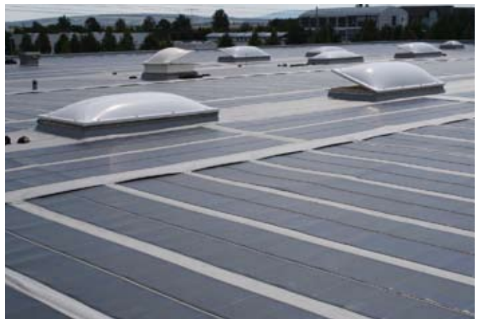
Abb. 4 Großflächige Eindeckung eines Gewerbebaus mit flexiblen PV-Dachbahnen – auch Durchbrüche für Lichtkuppeln und Installationen sind leicht zu realisieren © Centrosolar
