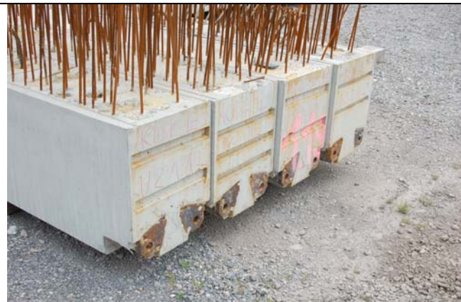
Bild 6 Stirnseite von Fertigteilriegeln mit Stützenfüßen im unteren Anschlusspunkt. (Bildquelle PFEIFER)
